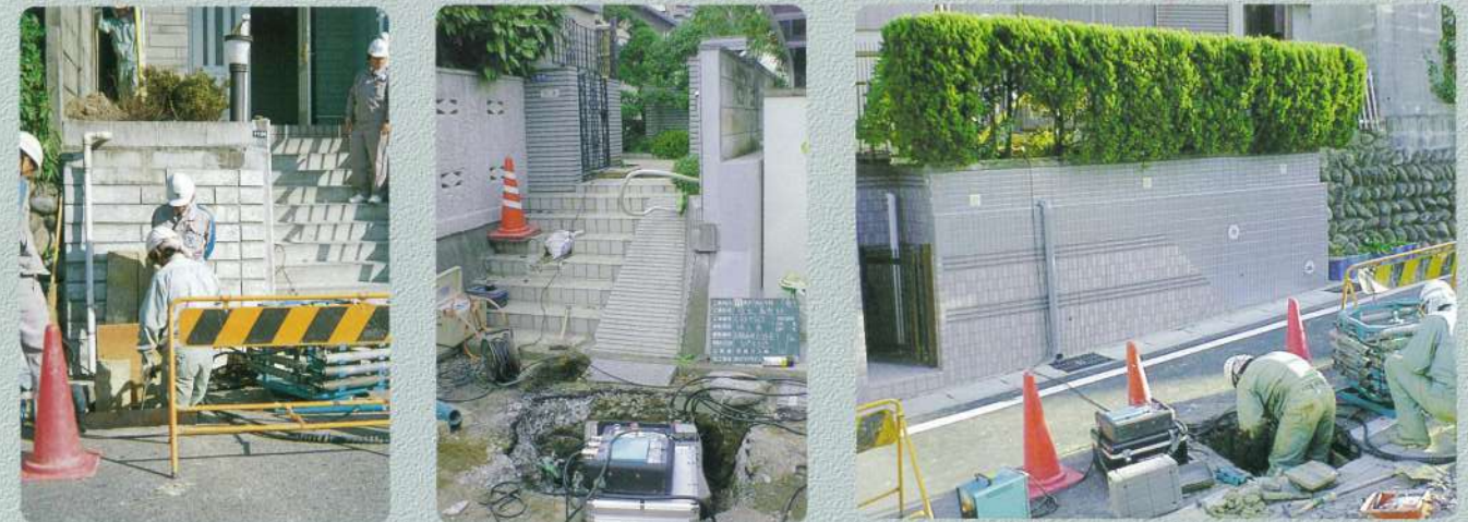
[高低差の大きい現場に] ヘッドが地表面まで自立して到達。高低差2.5mまで対応します。
