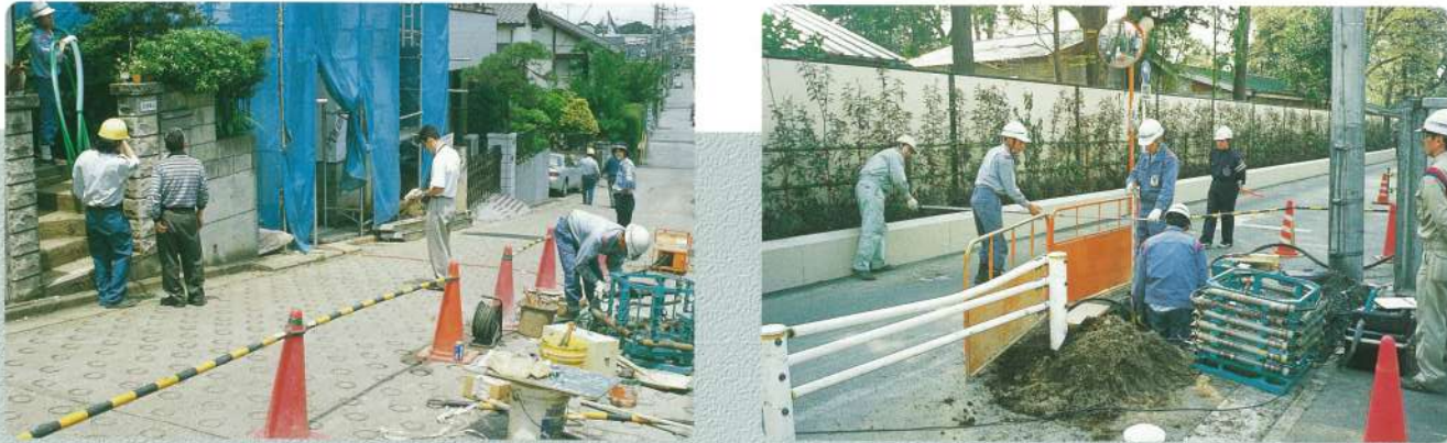
[道路を横断する現場に] 道路部の掘削が不要なため、通行を妨げる心配もありません。
