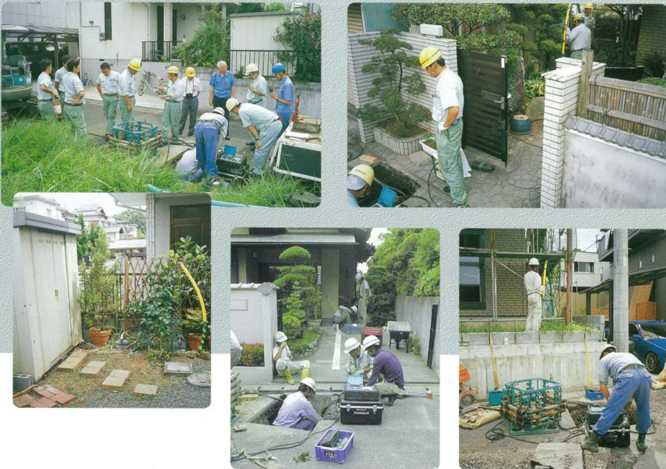
[障害物のある現場に] 到達部の掘削が不要なため、庭や車庫をまたぐ現場にも有効です。
