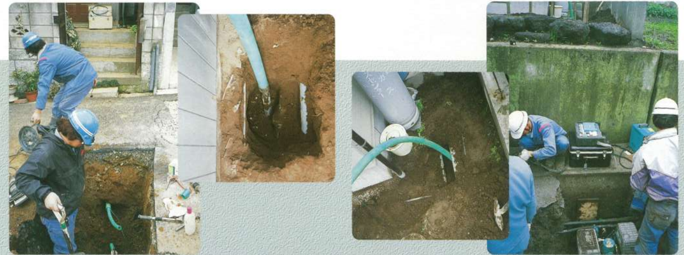
[高低差の大きい現場に] ヘッドが地表面まで自立して到達。高低差2.5mまで対応します。
