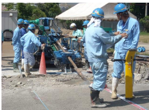
非開削工法による施工状況。ロケータで位置を計測している
