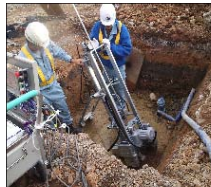
写真 - 1 NSWS による計測状況
