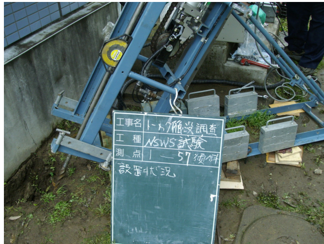
写真-4 NSWS による傾斜測定
