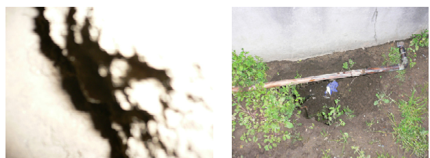
写真-3 空洞状況
