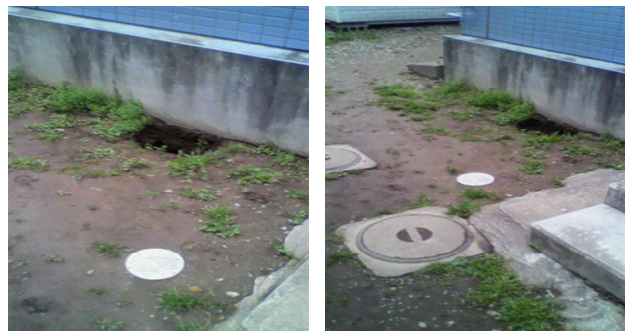
写真-2 陥没状況
