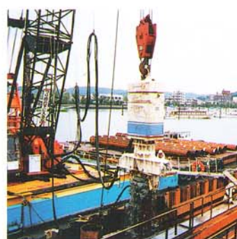
クレーン付台船による施工
