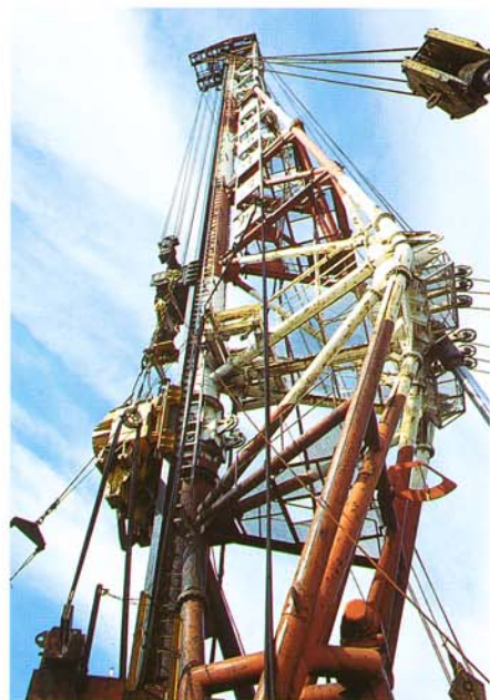
岸壁基礎鋼管杭の施工にあたるJV工法でのパイプロハンマ
