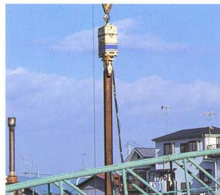
民家に近接しての低振動・低騒音施工
