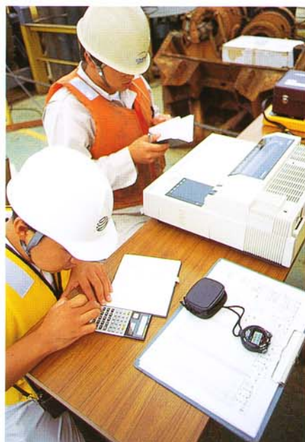
打止め管理と共に動的支持力を測定
