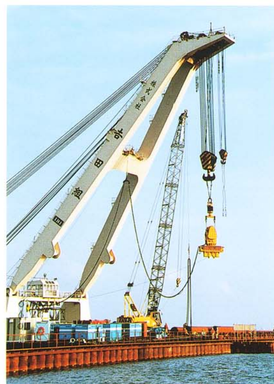
ジブ固定式起重機船による施工
