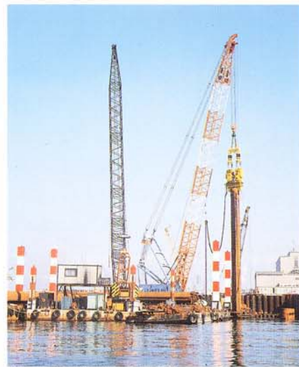
大径・長尺鋼管矢板の硬質地盤への打込み
