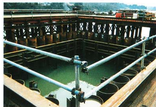
JV工法にて施工された仮締切り用鋼管矢板
