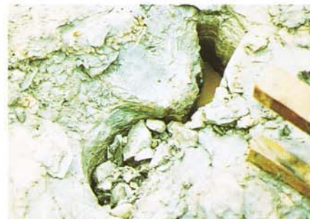
岩盤への鋼矢板打設の表層状況
