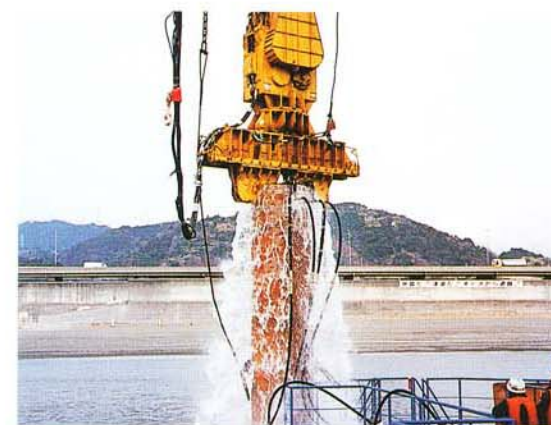
噴射水の大半を地表に還流し地盤の乱れを防ぐ
