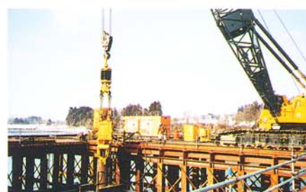
クローラークレーンによる施工
