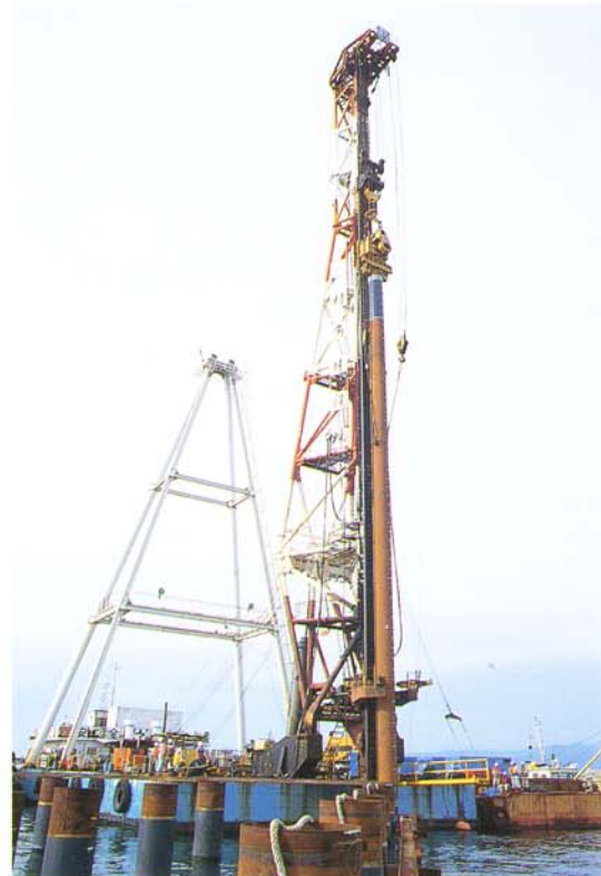
杭打船による施工
