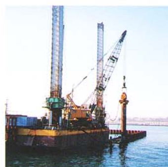
SEP上からの施工
