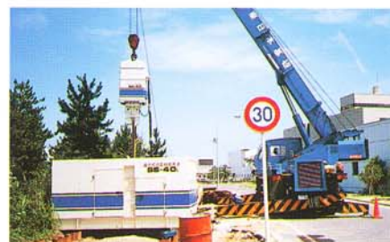
ラフテレインクレーンによる施工
