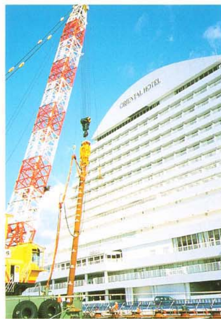
斜鋼管杭を硬質地盤に低公害施工
