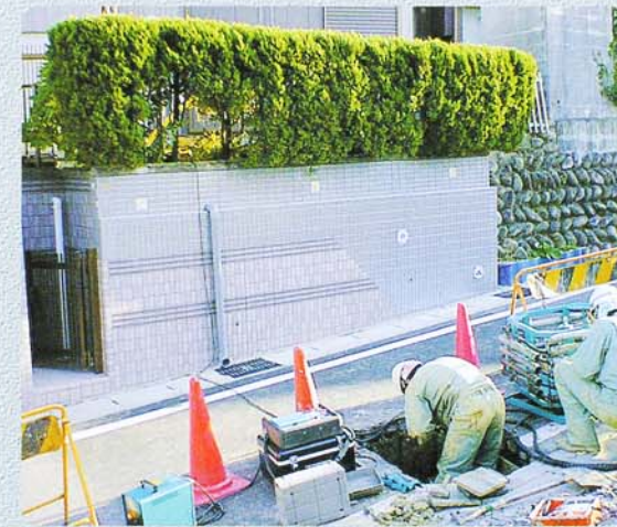
【高低差の大きい現場に】 ヘッドが地表面まで自立して到達。高低差2.5mまで対応します。
