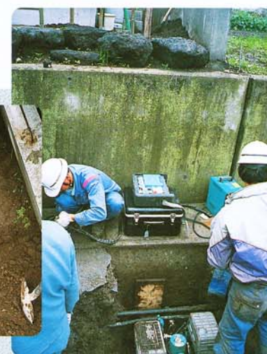
【高低差の大きい現場に】 ヘッドが地表面まで自立して到達。高低差2.5mまで対応します。
