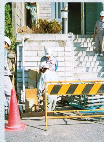
【高低差の大きい現場に】 ヘッドが地表面まで自立して到達。高低差2.5mまで対応します。
