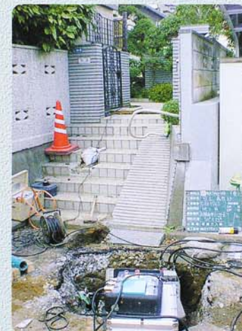
【高低差の大きい現場に】 ヘッドが地表面まで自立して到達。高低差2.5mまで対応します。
