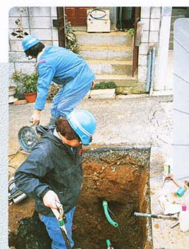
【高低差の大きい現場に】 ヘッドが地表面まで自立して到達。高低差2.5mまで対応します。
