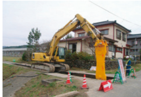
民家の近接部における改良施工
